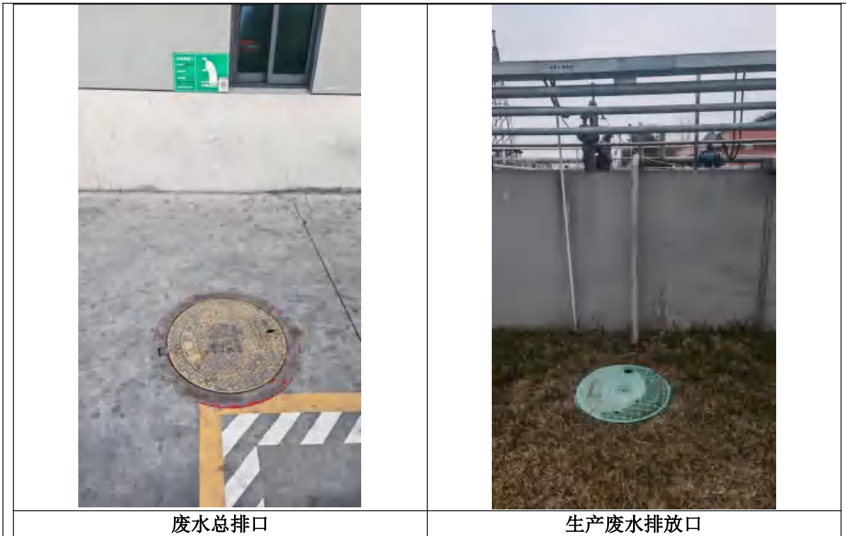
图 3-4 废水处理设施现场图
