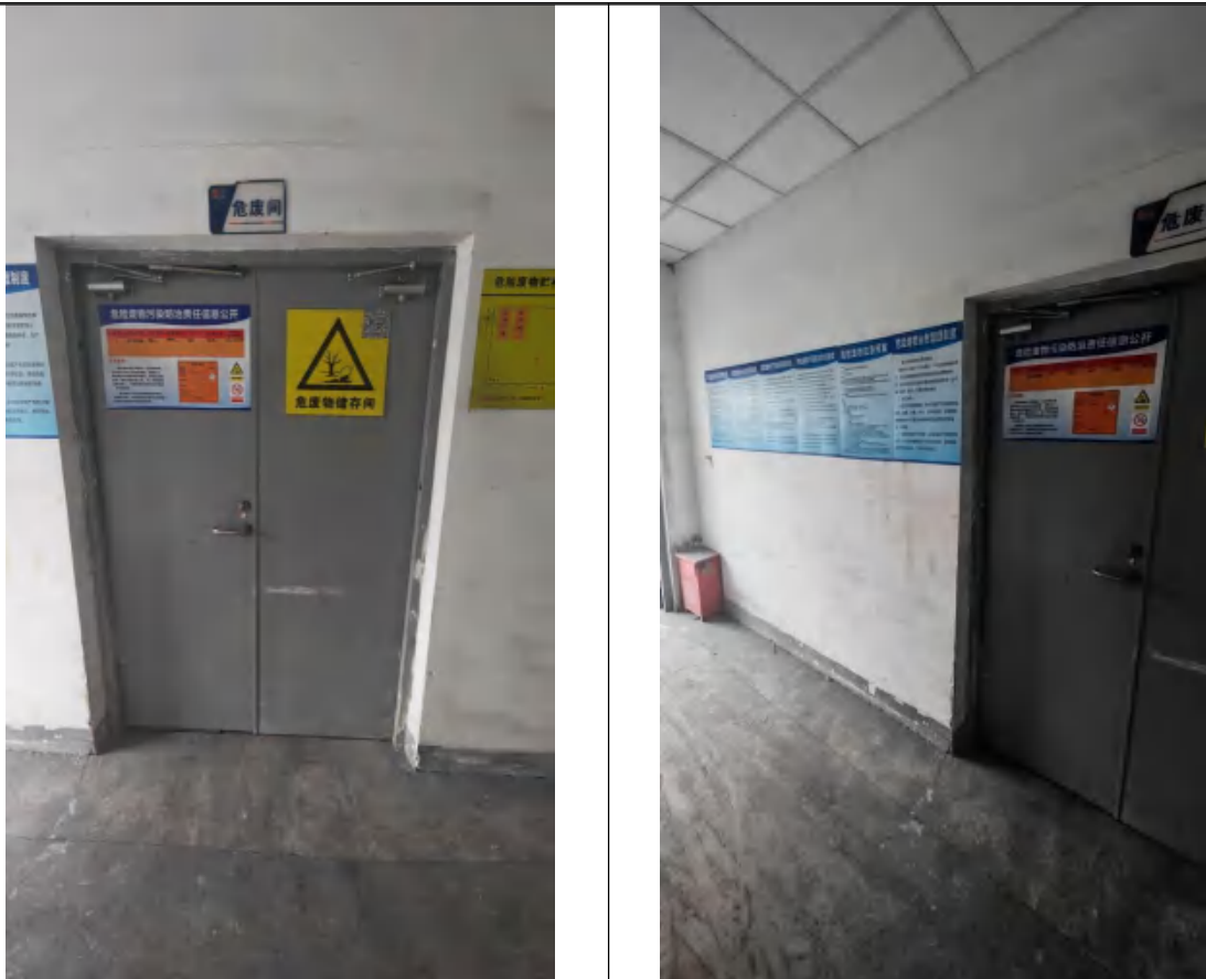
图 3-6 危险废物仓库现场图
