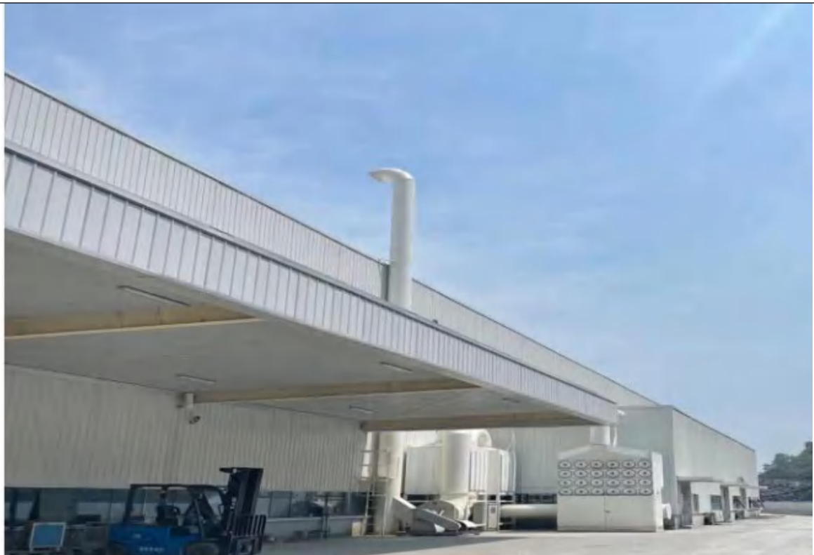
新型环保高性能仿石材质感砂浆系列产品-废气处理设施（已先行验收）
